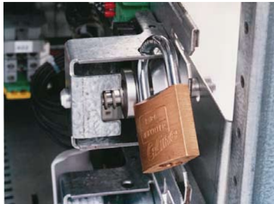
图. 61 用挂锁锁住抽屉机械机构
