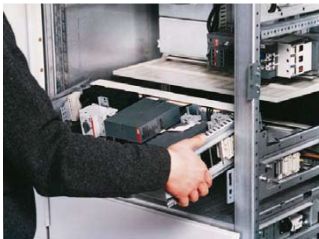
图. 62 导轨式抽屉的移出： • 稍微抬起抽屉并把他拉出 • 用手抓住抽屉两侧把他全部拉出 • 把辅助手柄移走
