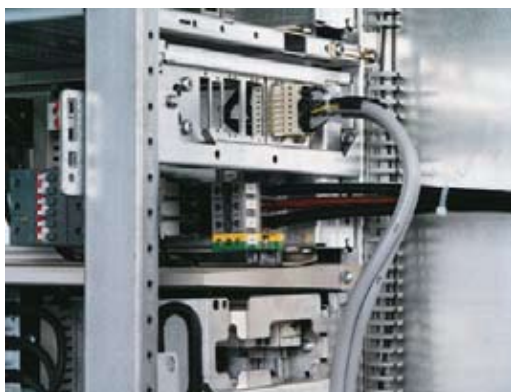
图. 74 移除抽屉前要先断开电源和控制电缆（例子：导轨式）
