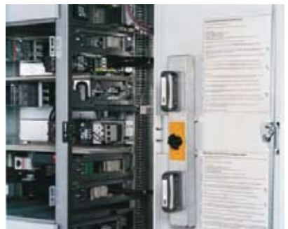
图. 78 带操作手柄和操作说明的开启的门
