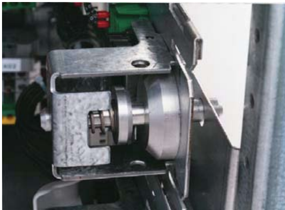
图. 60 导轨式抽屉的联锁
