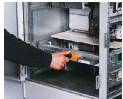
图. 80 解锁抽屉模块的同时锁住操作手柄
