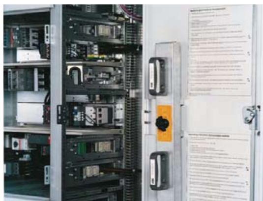
图. 55 有辅助手柄和操作说明的电缆室门
