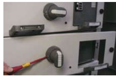
图. 84 使用螺丝刀卸下抽出式抽屉的前面板
