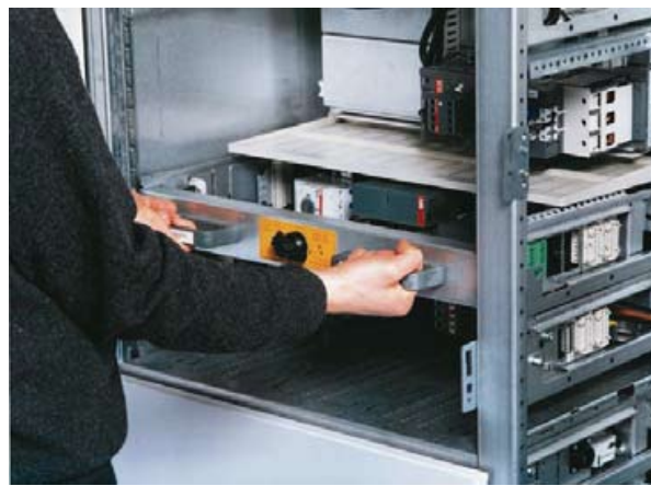
图. 58 在解开辅助手柄的同时锁住抽屉；拿出辅助手柄。
